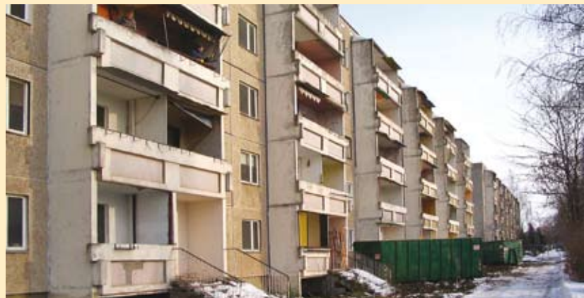
Damals begehrt, heute leer: die Wohnhäuser im Wohngebiet Bernburg/Süd-West
