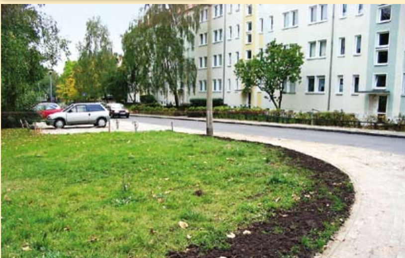
Großzügig, bequem und sicher: Im Puschkinweg und in der Gorkistraße wurden die Gehwege erneuert.
