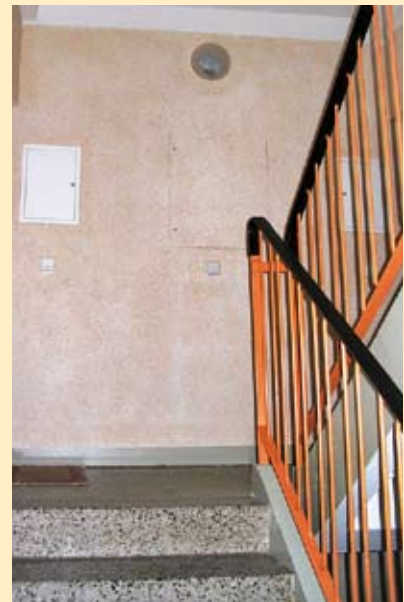
Im Wohnblock Vor dem Nienburger Tor 49 - 52 wurden die Treppenhäuser saniert.
